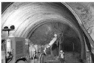
大型ブレイカーによる掘削状況
